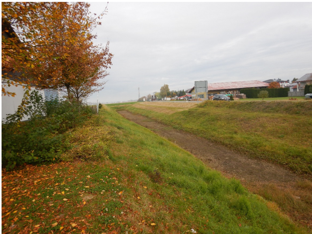
Abbildung 6: Blick nach Nordosten auf das Versickerungsbecken. Am Ende des Beckens grenzt die Vorhabenfläche an.
