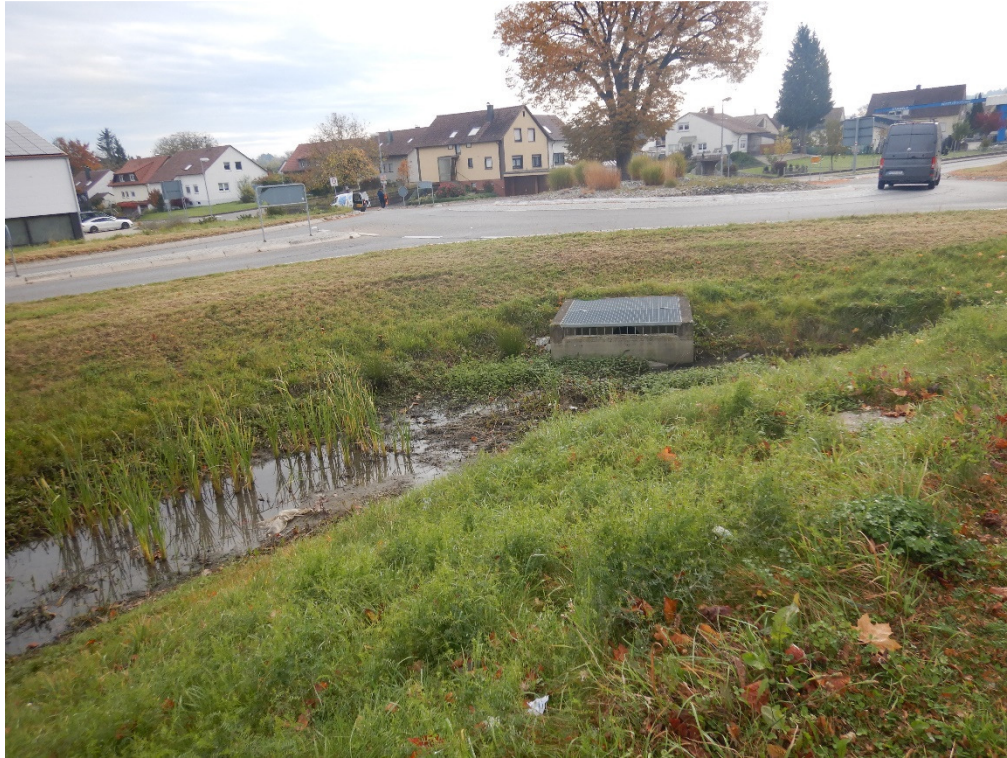
Abbildung 7: Blick nach Südosten auf das Versickerungsbecken.
